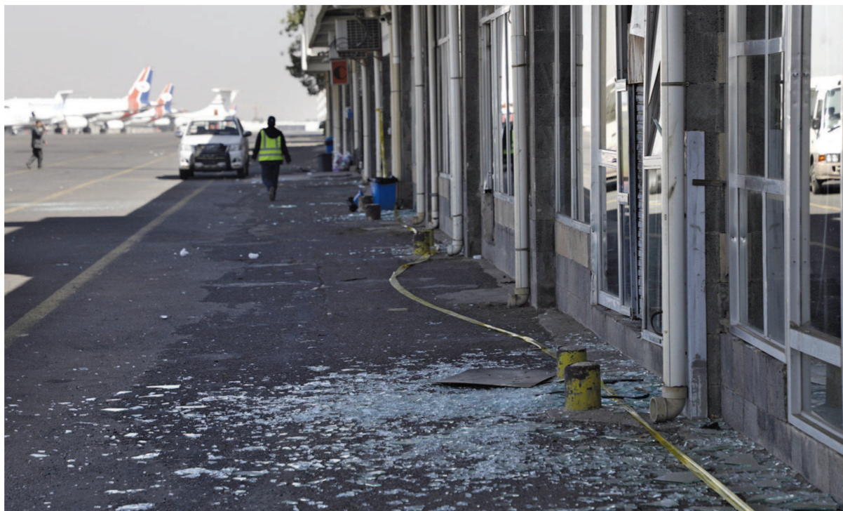
27日，也门萨那国际机场，工人走过以色列空袭后留下的破碎玻璃。视觉中国
