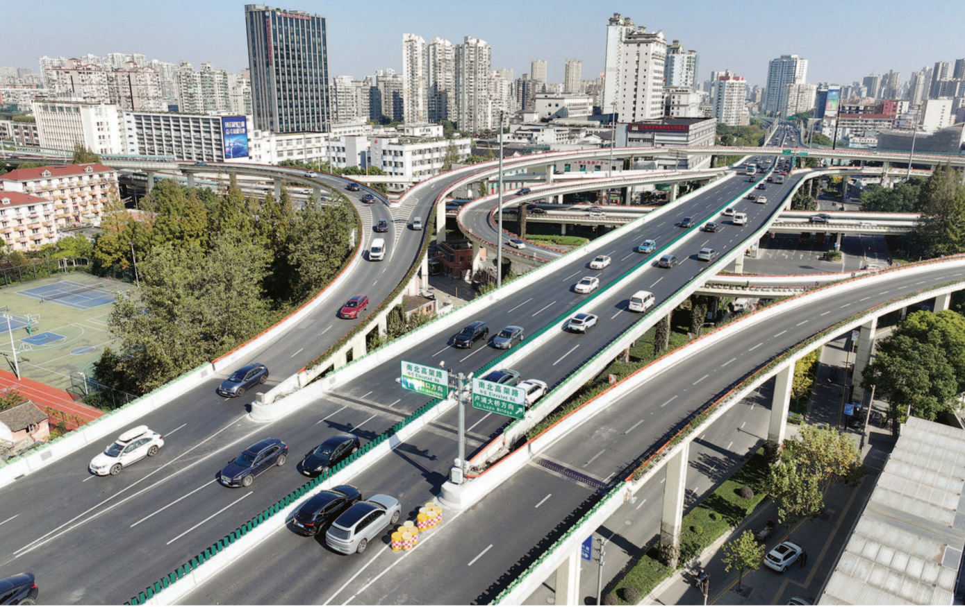
内环“年轻化”三期工程在历时140余天的施工后完成改造，将为上海市民提供更安全、舒适的交通服务。（采访对象供图）
