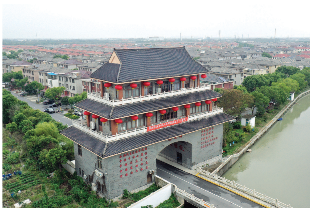
杨王村塔楼后方的杨王村，总共建设了1093套房屋，解决了村民的宅基地置换问题。（受访者供图）
