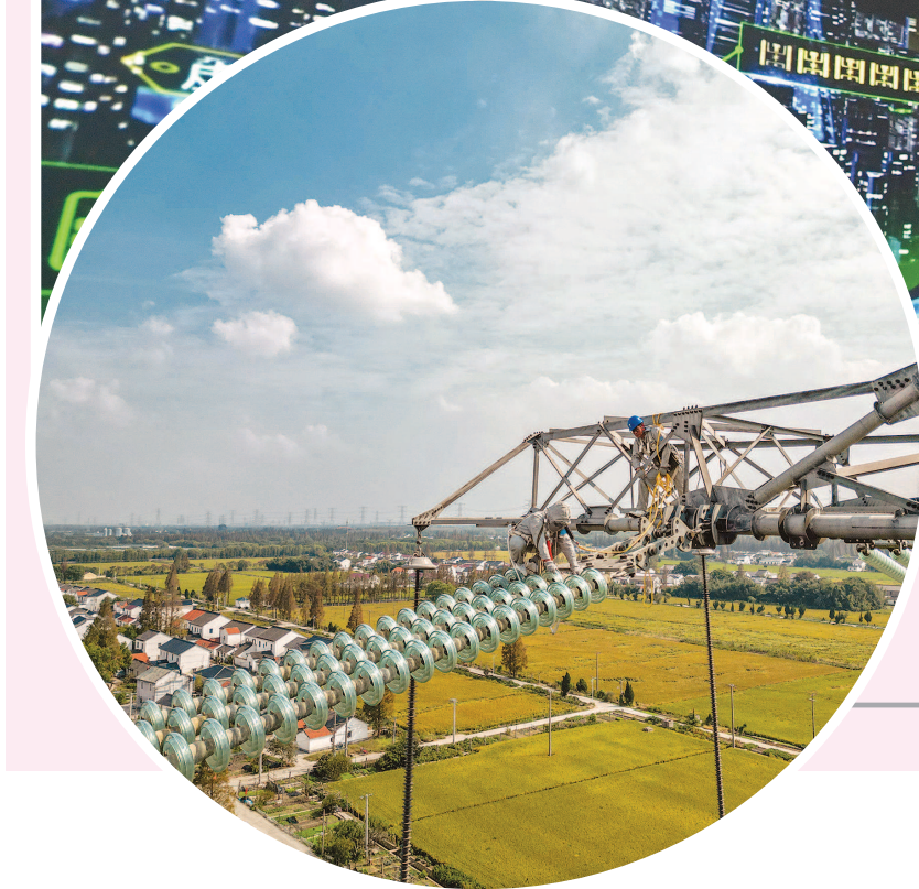
▲国网上海电力虚拟电厂运营体系。 ▼国网上海超高压公司输电检修人员开展1000千伏特高压安塘II线带电作业。
