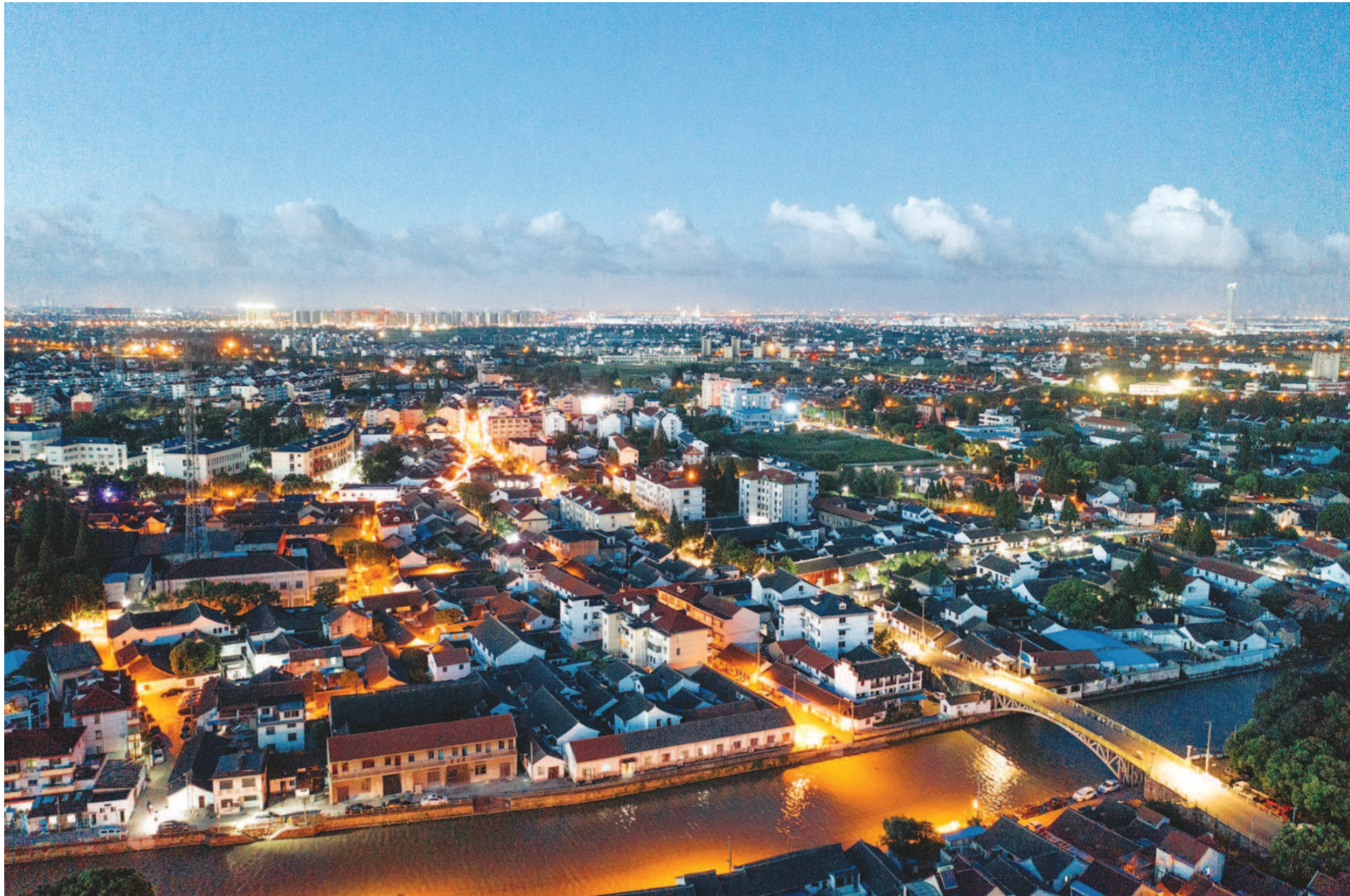
张堰古镇历史风貌保护区俯瞰。
