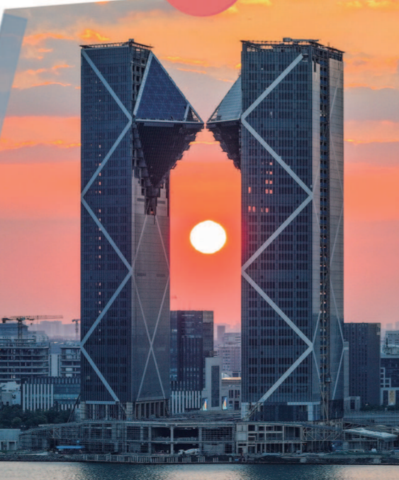
临港新片区滴水湖西岛上在建中的上海中银金融创新中心沐浴夕阳余晖。 本报记者 邢千里摄
