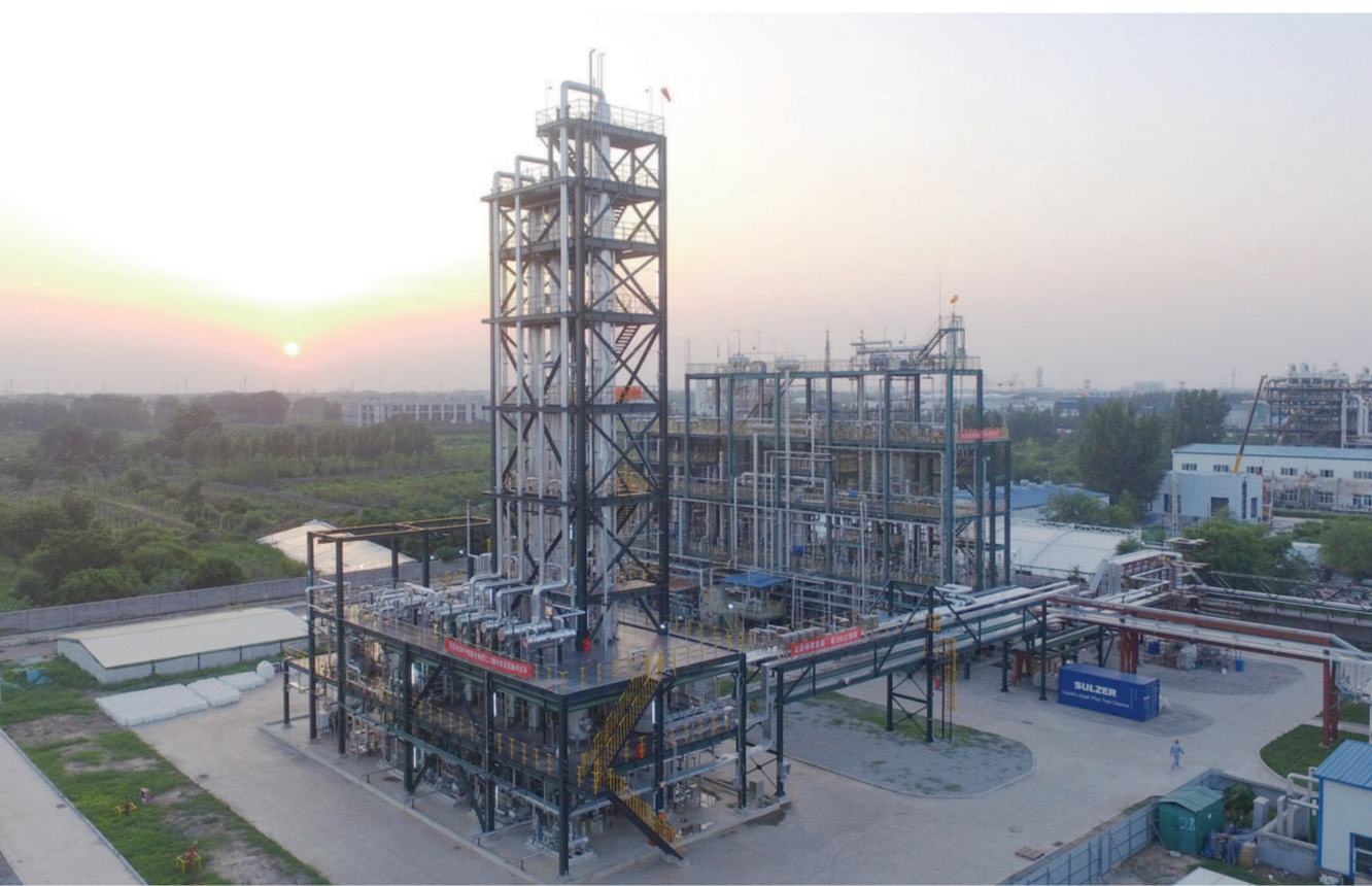
千吨级生物质催化转化制乙二醇装置。
