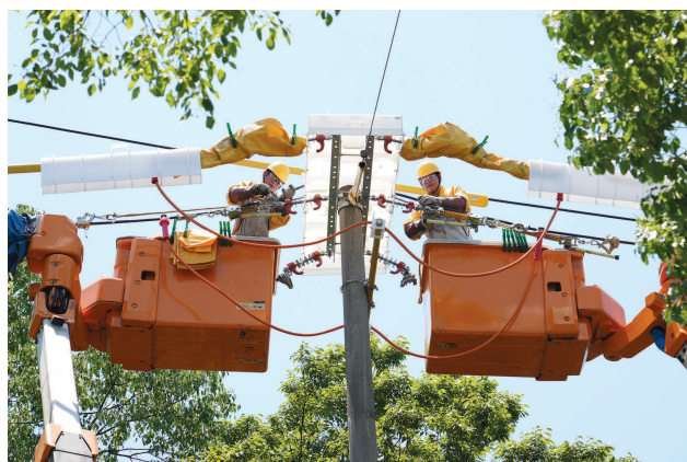
国网上海嘉定供电公司带电作业人员在裕民路群裕路路口带负荷直线杆改耐杆并加装柱上开关，进一步优化网架结构，保障可靠供电。
