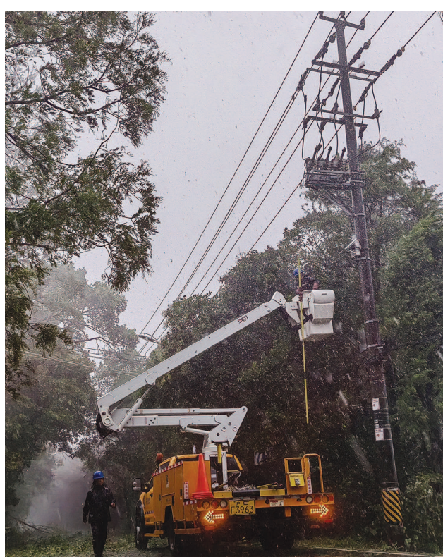
国网上海奉贤供电公司抢修人员高浩天在奉贤区海湾镇一根电杆附近抢修因树木倒伏引发的断线故障。(均上海电力供图)
