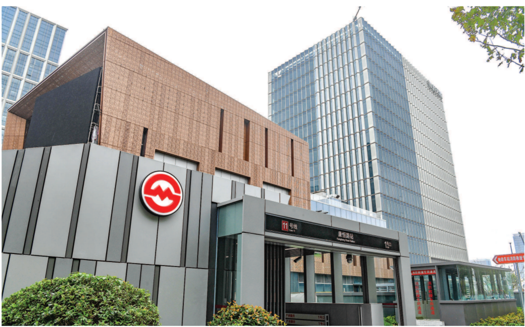
康恒路站是上海首个在既有运营线路上改造建成的地下车站。
