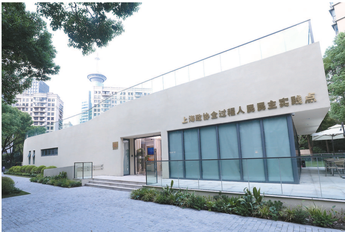
图为上海政协全过程人民民主实践点。金松摄
