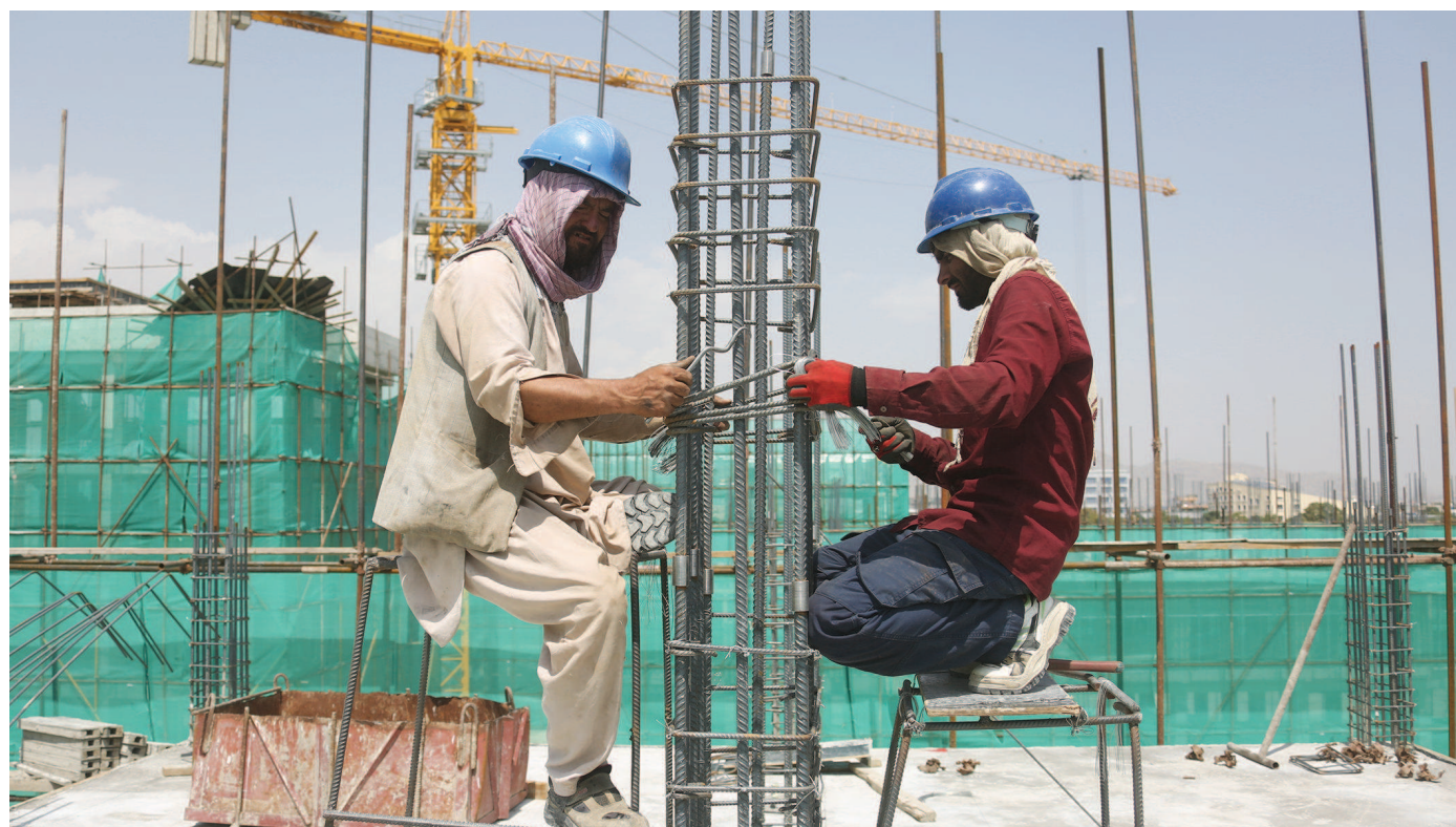
8月24日,在阿富汗首都喀布尔,工人在中国十九冶集团有限公司援建的住宅楼项目工地施工。
