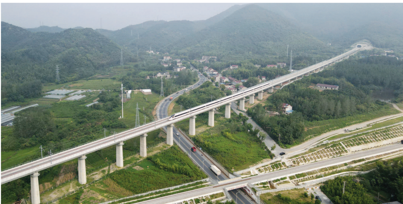
8月29日,试运行列车行驶在宣绩高铁线路上。
