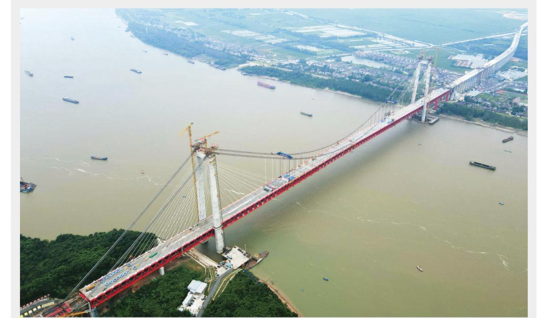
8月27日，由中铁大桥局承建的G3(京台高速)铜陵长江公铁大桥主桥合龙。该桥是一座双层斜拉—悬索协作体系大桥，全长11.88公里，主跨988米，具有高速公路、城际铁路、货运铁路三种过江功能。大桥计划于2025年建成，建成通车后对于加快区域协调发展、加强长三角互联互通具有重要意义。图为G3(京台高速)铜陵长江公铁大桥合龙现场(无人机照片)。
