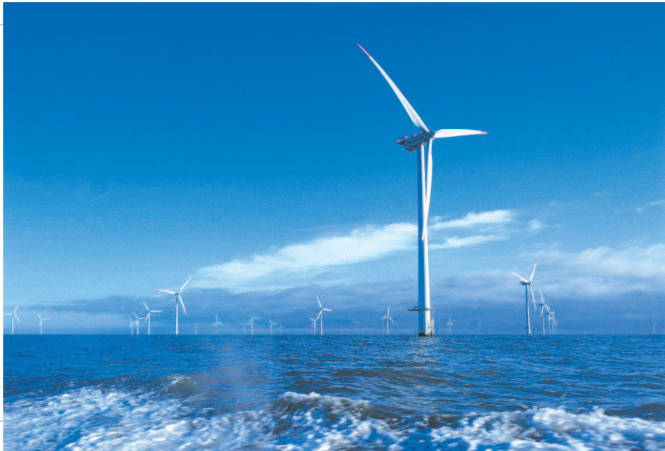
上海以加快清洁能源安全高效的新能源体系体系建设推动 新源结构调整,图为上海东海大桥海上风电项目。 图片来源:上海电力
