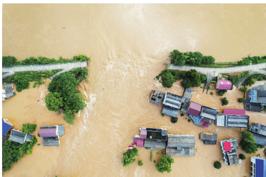
7月29日拍摄的涓水湘潭县河口镇华中村堤段决口险情现场(无人机照片)。新华社记者 陈思汗摄
