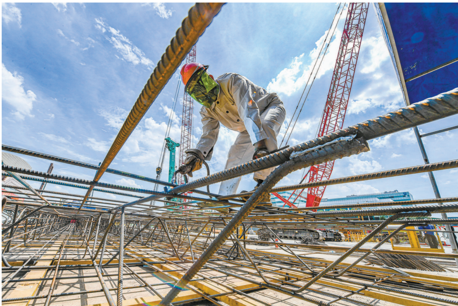
▲烈日炙烤下,轨道交通13号线东延伸段丹桂路站工地内,为保障进度,地铁建设者们不惧“烤”验,对地下连续墙进行焊接。 本报记者 张伊辰 摄
