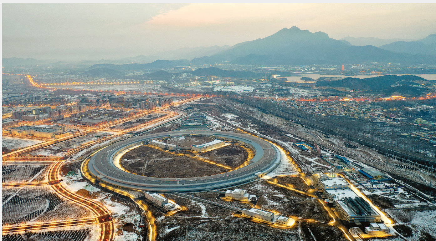
昨日，国家重大科技基础设施高能同步辐射光源（HEPS）的储存环完成全环真空闭环，标志着储存环全环贯通，进入联调阶段。高能同步辐射光源储存环流轨道周长约1360.4米，用于储存高能高品质电子束，同时产生同步辐射光，是世界上第三大光源加速器，国内第一大加速器。图为高能同步辐射光源（HEPS）全景（无人机照片，2023年12月11日摄）。
