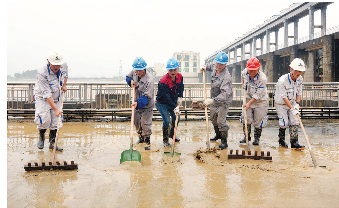
6月19日,在广西柳州市融水苗族自治县古顶水电站,工人在洪水退后清淤。
