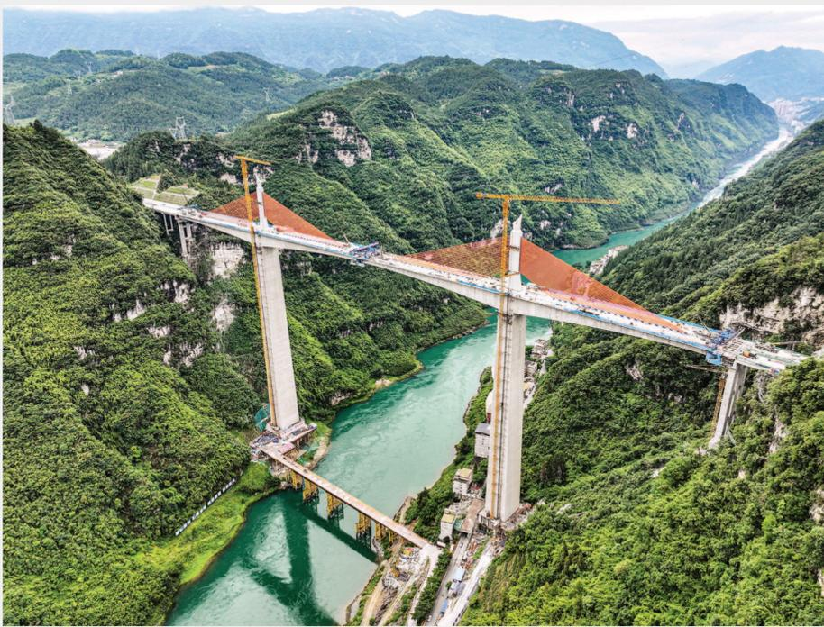
近日，位于重庆市彭水苗族土家族自治县境内的渝湘复线高速磨寨乌江特大桥进入最后一节2米连续梁浇筑施工作业，该桥即将实现全桥合龙。磨寨乌江特大桥由中铁建重庆投资集团有限公司投资，中国铁建港航局集团承建，桥梁全长708米、主跨296米。渝湘复线高速总里程280公里，平均桥隧比80%。今年内渝湘复线高速巴南至武陵段、彭水至酉阳段将建成通车，2025年有望全面建成通车。图为6月9日拍摄的渝湘复线高速磨寨乌江特大桥建设现场（无人机照片）。
