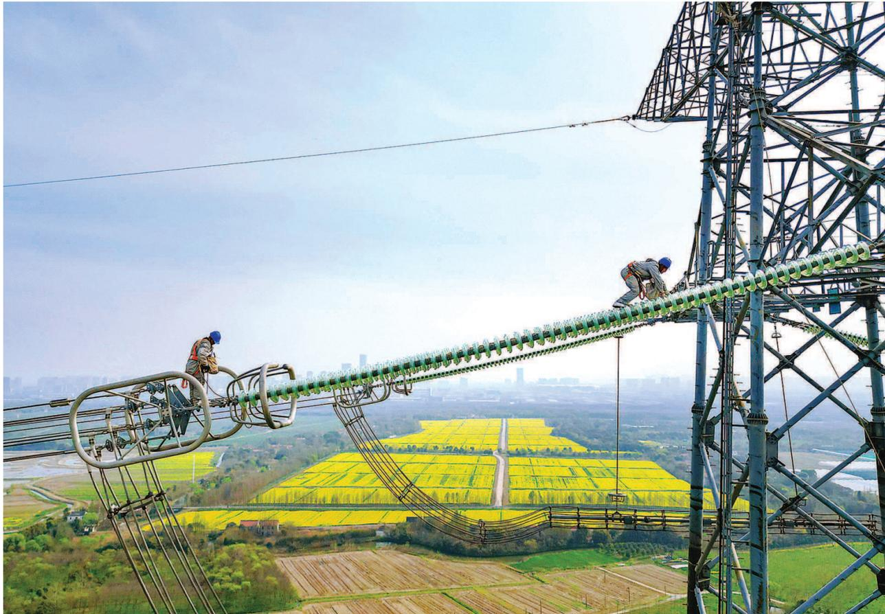
国网上海超高压公司检修人员在1000千伏吴塘II线路登塔开展瓷质绝缘子和导线金具消缺检查。
