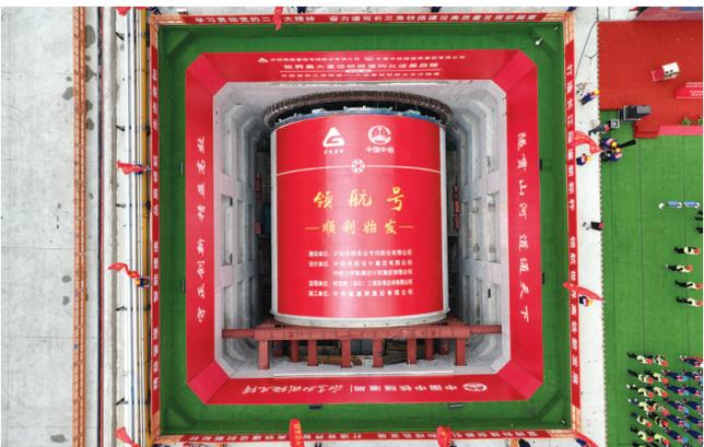
本报讯(记者张晓明)昨天,在万里长江的人海口崇明区万安村建设现场,由我国自主研发、世界最大直径高铁盾构机——新建上海至南京至合肥高速铁路崇太长江隧道“领航号”盾构机顺利始发。隧道建成运营后,将首次实现高铁穿越长江不减速的壮举。图为“领航号”盾构机始发掘进现场。(受访者供图)
