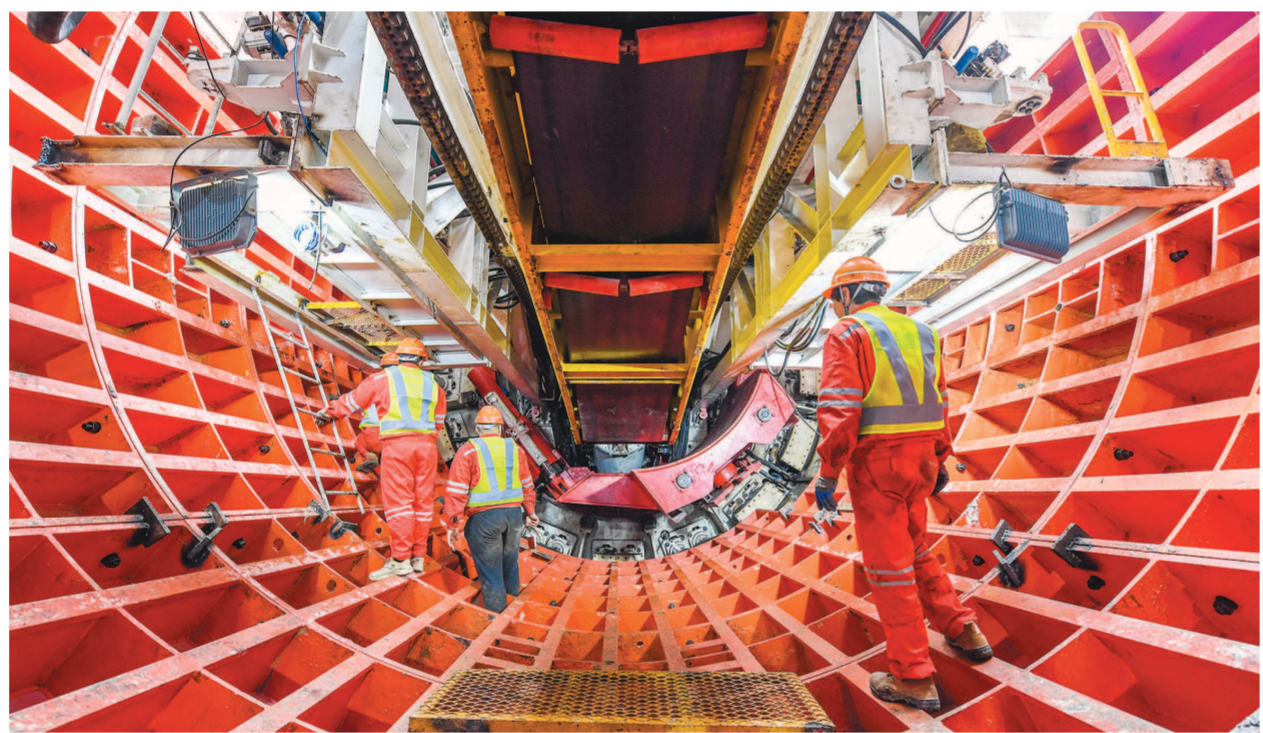
昨天,18号线二期工程土建3标盾构机顺利始发。
