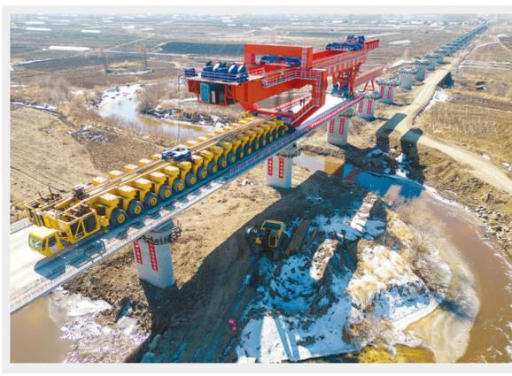
昨日，在位于黑龙江省绥化市庆安县的哈伊高铁哈尔滨至铁力段施工现场，历时近1小时的架梁作业后，长32米、重约750吨的箱梁稳稳架设在安邦河特大桥墩上，标志着哈伊高铁哈铁段建设进入架梁施工阶段。哈伊高铁是我国在建跨度最高、全线所处地区全年温差最大、首条穿越多年岛状冻土区的高速铁路。
