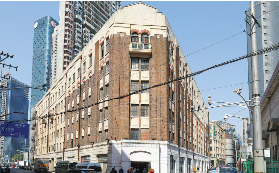
昨天，德邻公寓更新项目正式开工。
