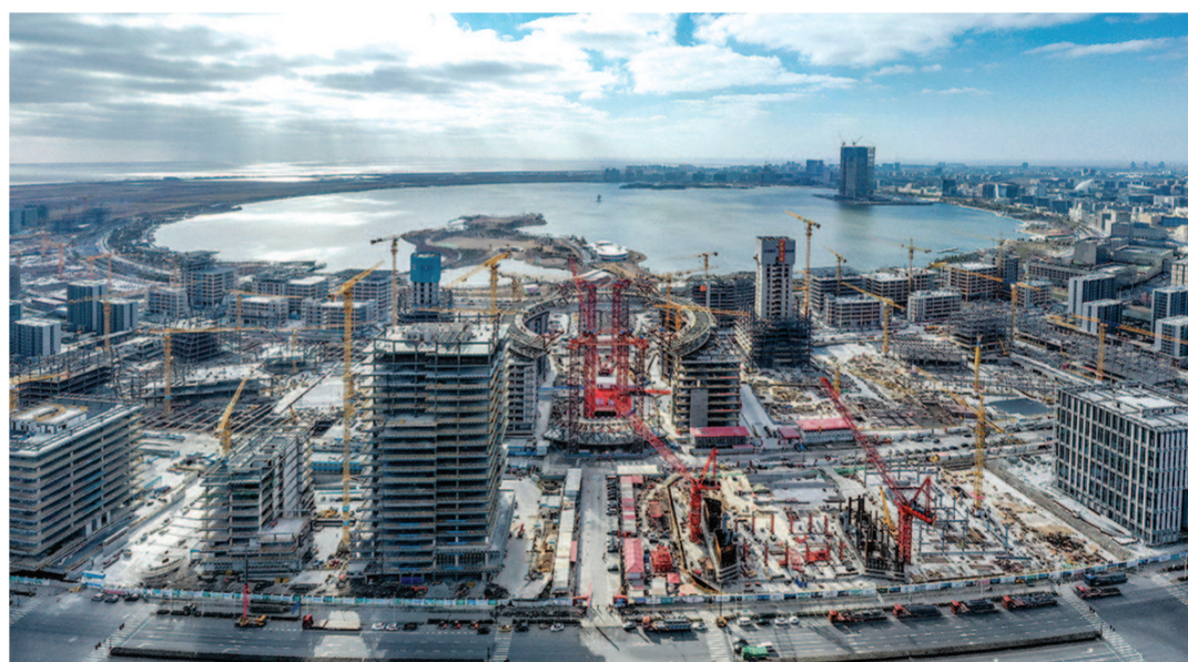
图为临港新片区金融湾综合龙起吊仪式现场。本报记者邢千里摄
