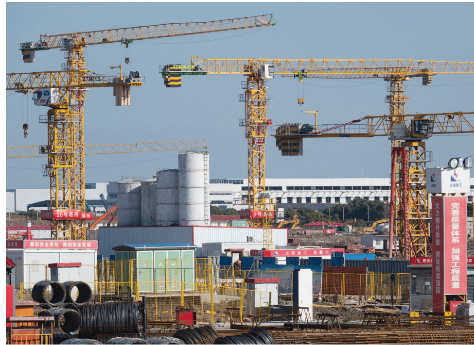
上海东方枢纽上海东站工地现场。
