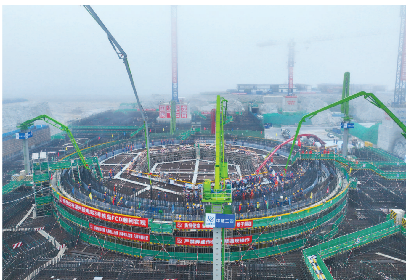
“华龙一号”3号机组全面开工 昨天，中核集团漳州核电二期工程“华龙一号”3号机组开工建设。图为“华龙一号”3号机组浇灌核岛第一罐混凝土浇筑现场（无人机照片）。 新华社发
