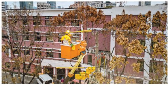
员正在嘉善路对高损 耗变压器更换后的新 设备进行带电接入。
