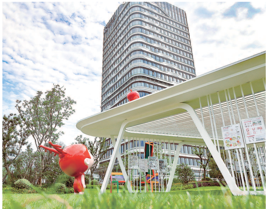
古美公园被打造成为全国首个城市家具公园。
