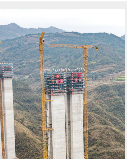
昨天，由贵州公路集团承建的贵(阳)平(塘)高速公路南明河特大桥主墩全部顺利封顶。南明河特大桥是贵平高速的控制性工程之一，为多跨连续刚构桥，全长1129.8米。
