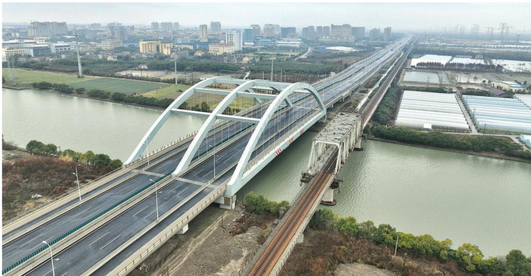
金汇港大桥全长679.58米，跨越金汇港通航河道，主跨为125米的下承式钢箱梁系杆拱桥。 本报记者 张伊辰 通讯员 张琛摄
