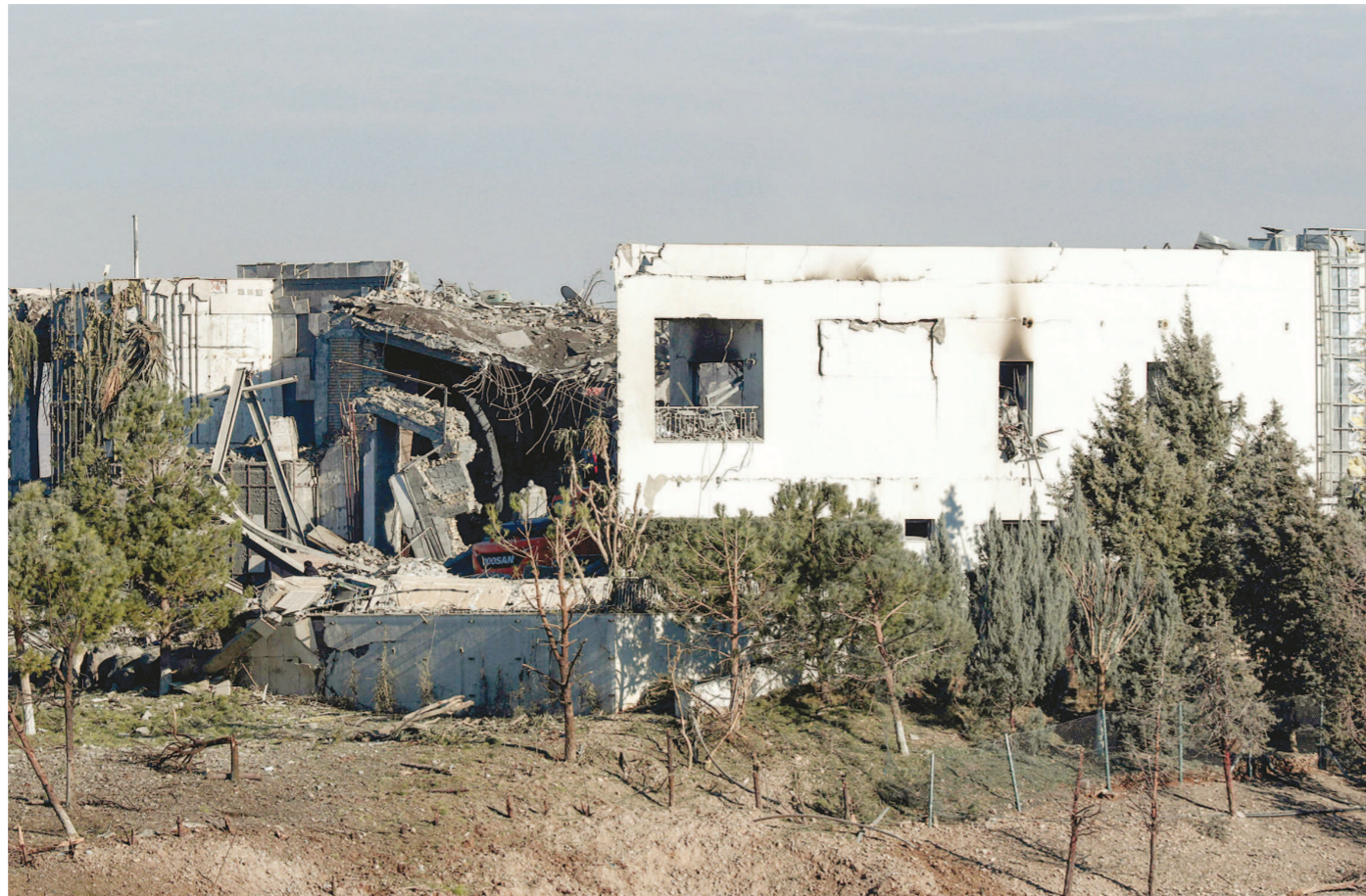
这是1月16日在伊拉克北部库尔德自治区埃尔比勒拍摄的被伊朗导弹袭击后的建筑。
