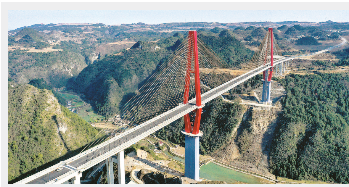
目前，由中交二公局承建的贵州龙里河大桥建设已进入收尾阶段，预计今年上半年实现通车。龙里河大桥位于贵州省龙里县境内，是龙溪大道工程向龙里大草原等景区延伸的控制性工程，项目建成后将更好地服务当地旅游业发展和山区群众出行。图为1月3日拍摄的贵州龙里河大桥（无人机照片）。新华社记者 杨文斌摄
