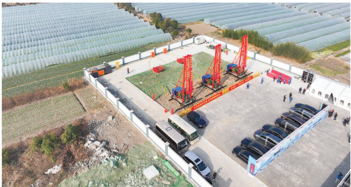
昨天，市域铁路南枫线一期工程开工。
