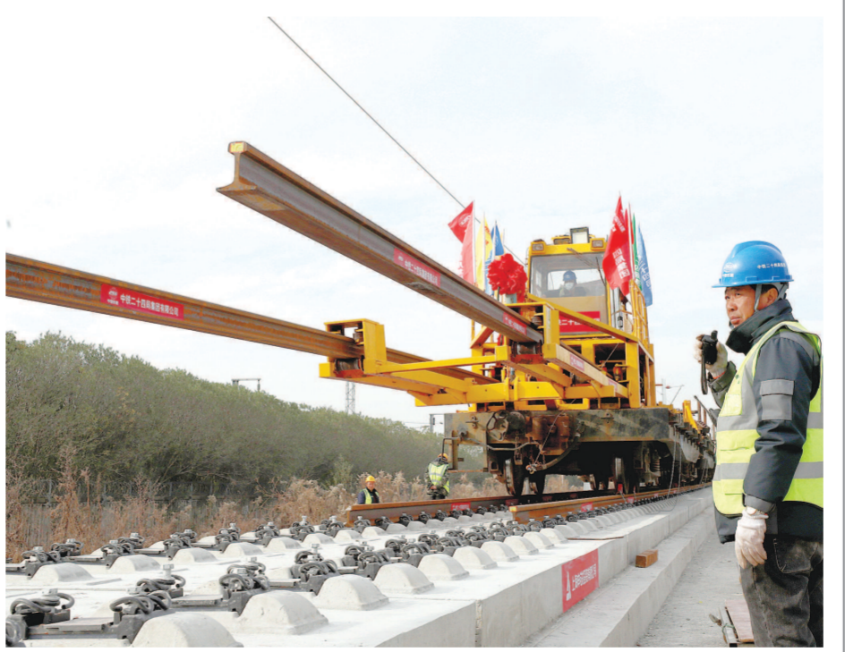
昨日，在机场联络线七宝站，轨道推送车在工人指挥下将两根500米长钢轨从长轨运输车推出。新华社记者 方喆摄
