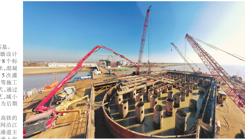
4号主墩钢围堰封底施工现场。 李梦竹摄
