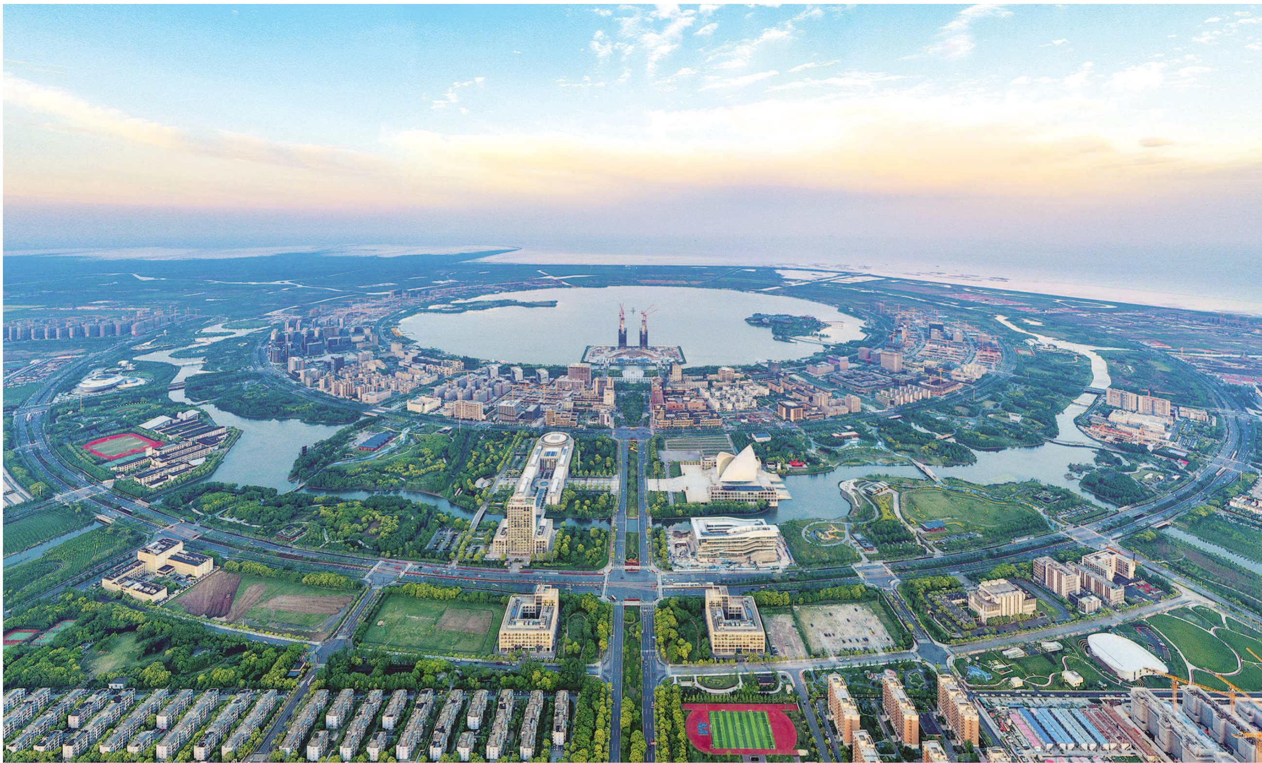
今年是中国改革开放45周年,临港新片区将加快打造滴水湖金融湾,建设国际数据港,推动新片区拓展特殊经济功能、推进高水平制度型开放。图为临港新片区滴水湖。
