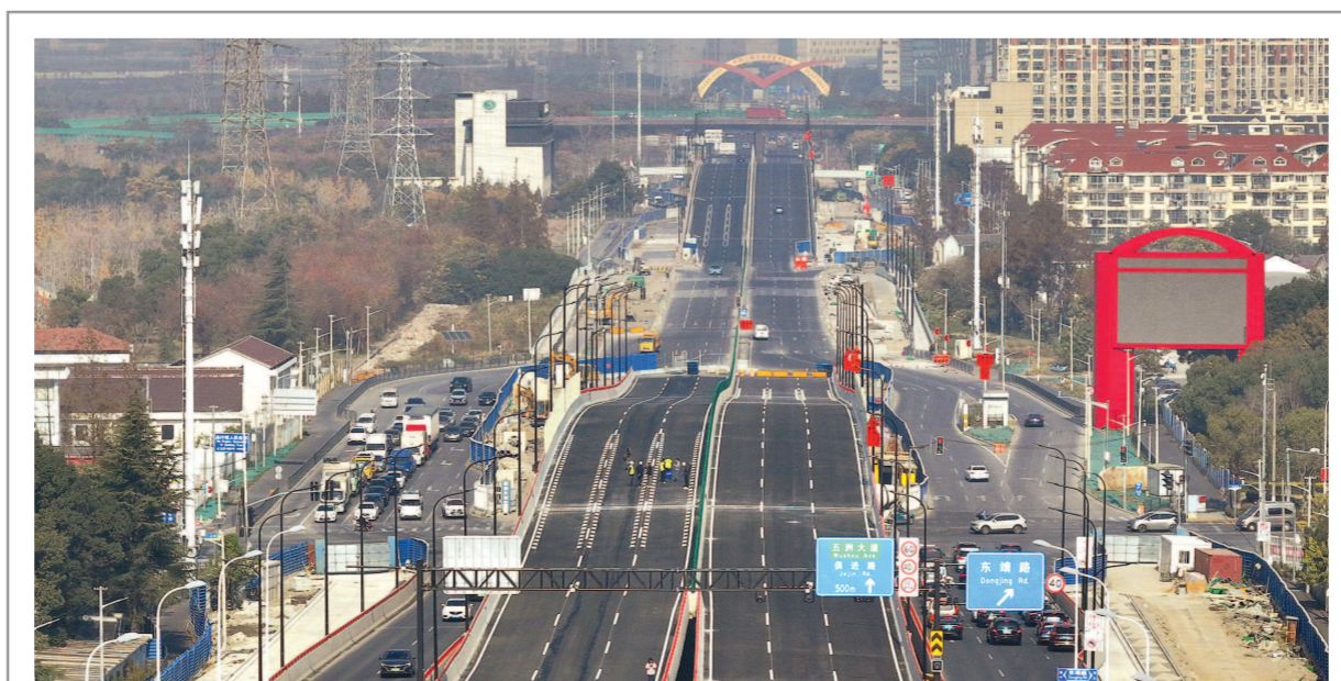
杨高北路改建工程主线今天竣工通车
