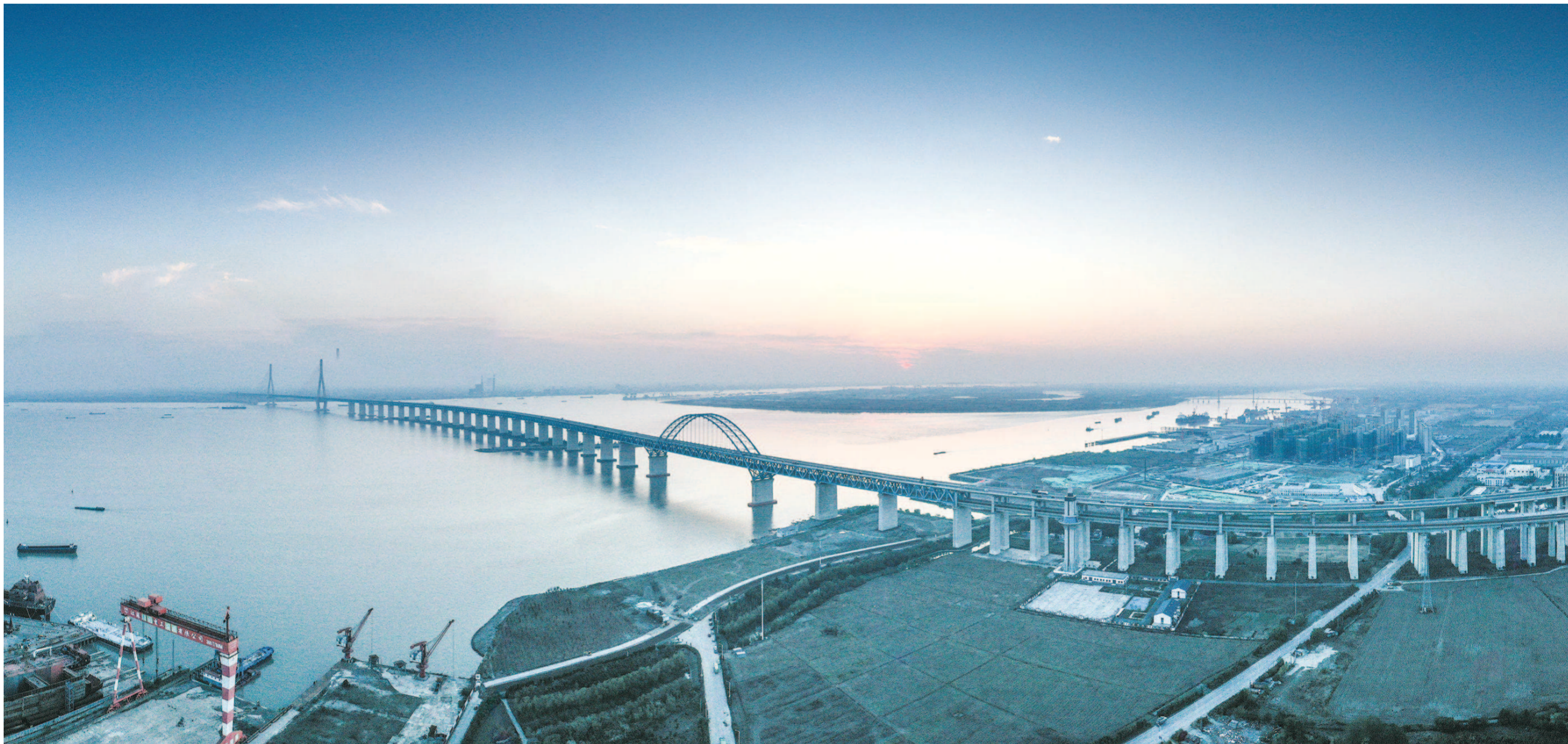
5年来,长三角互联互通不断加快,各地之间的往来更加便捷。图为沪苏通长江公铁大桥沿岸景色(2021年11月12日报,无人机照片)。
