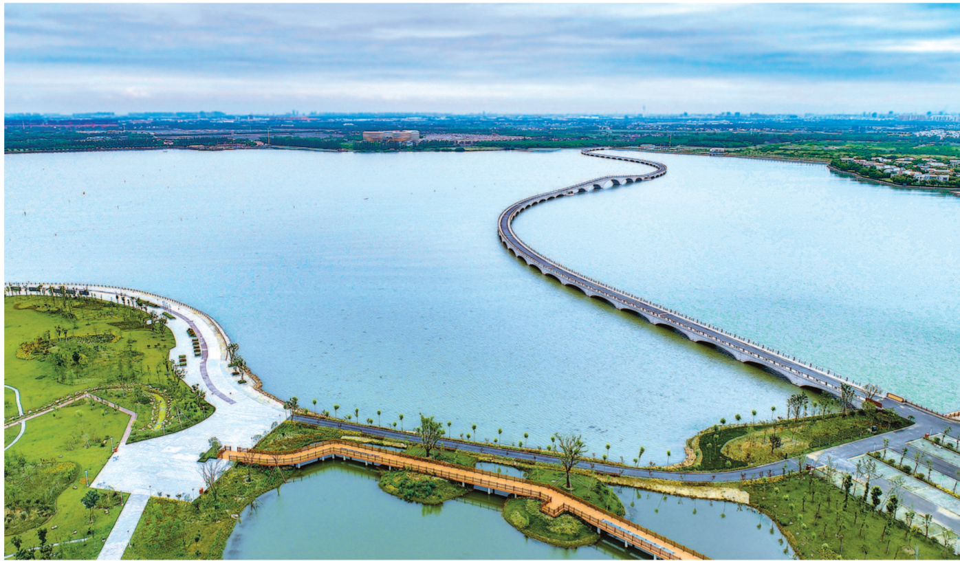
元荡生态岸线贯通工程三期(青浦段)已顺利完工,成为附近小有名气的网红打卡地。
