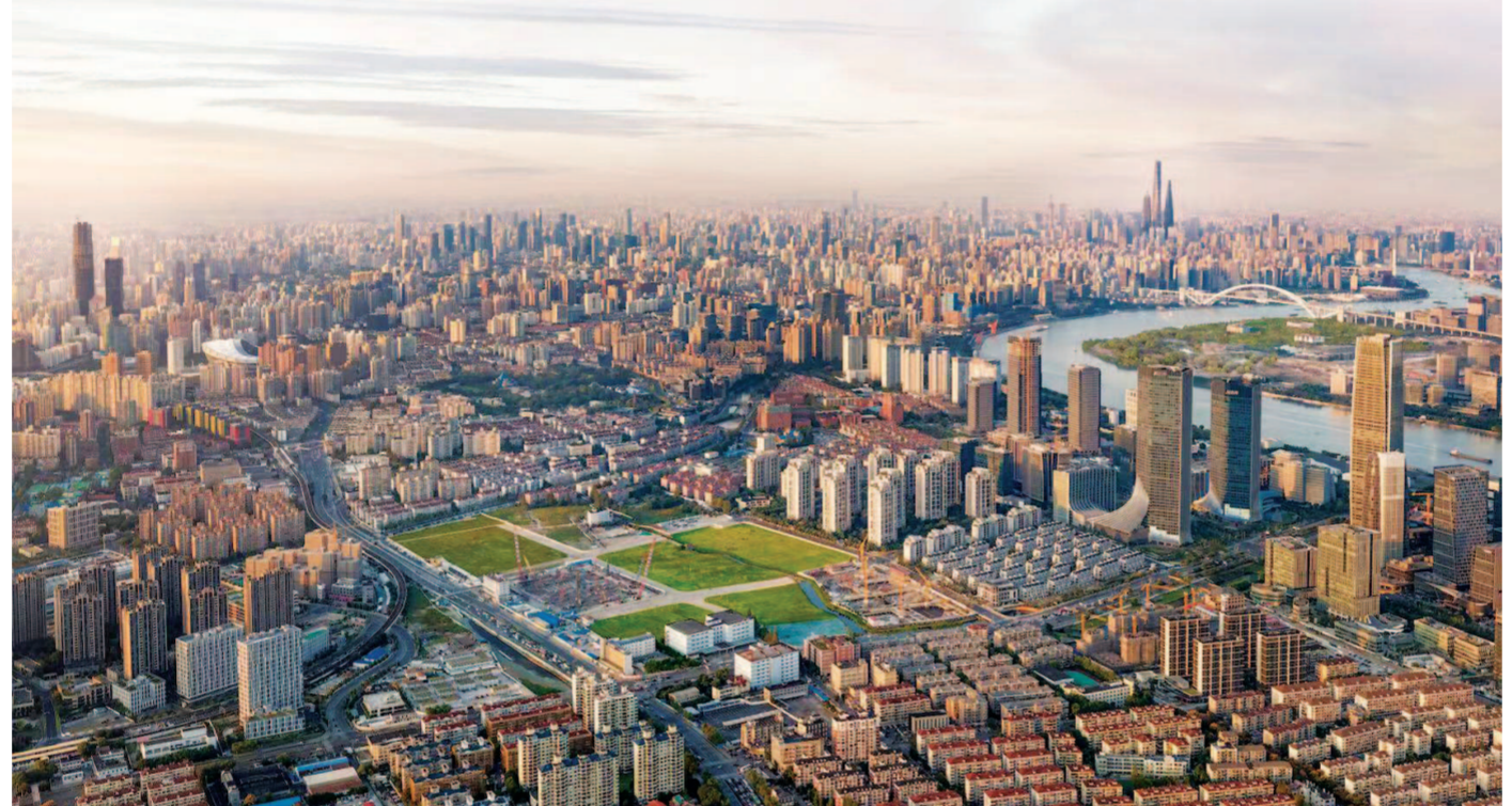
位于龙吴路、龙耀路、天钥桥南路、龙恒路围合区域的西岸数智中心。（采访对象供图）
