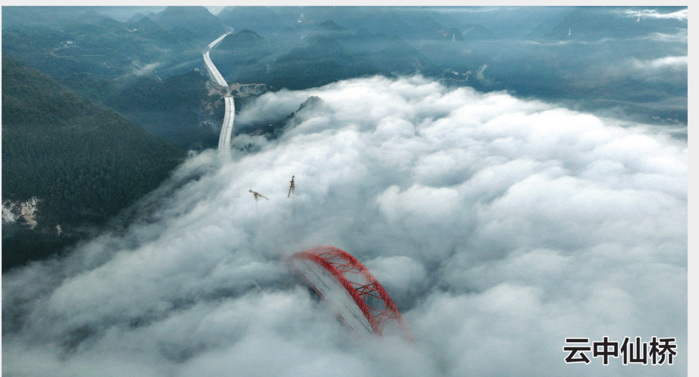
淩水河特大桥位于湖北省恩施土家族苗族自治州鹤峰县境内，是宜来(宜都市至来凤县)高速公路鹤峰东段的控制性工程，大桥全长328米，横跨300多米深的峡谷。图为11月20日拍摄的建设中的淩水河特大桥(无人机照片)。
