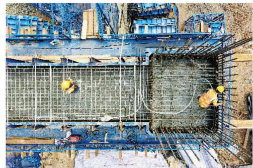
目前，由中铁四局等单位建设的沪昆高速扩容工程安盘至盘州段正在加紧建设，进展顺利。据了解，沪昆高速扩容工程安盘段全长约173公里，设计时速100公里，设计为双向六车道高速公路。图为11月1日，正在进行桥墩施工的双猴冲大桥(无人机照片)。
