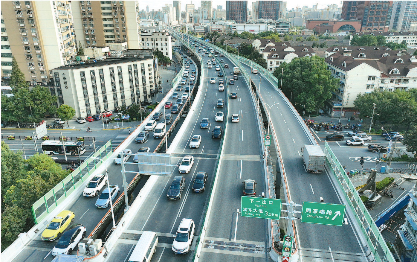
内环高架设施提升及功能完善工程外圈施工完成。
