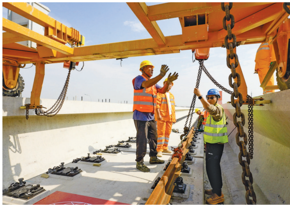
昨天上午，施工人员将首对25米钢轨精准平稳地铺设在无砟轨道板上，标志着上海轨道交通17号线西延伸工程进入轨道工程施工阶段。本报记者 张伊辰 通讯员 冯昊摄
