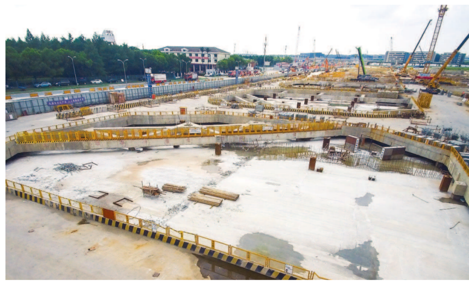
建设中的申昆路停车场，未来将成为国内首例置于地下的市域动车组停车场。(受访者供图)
