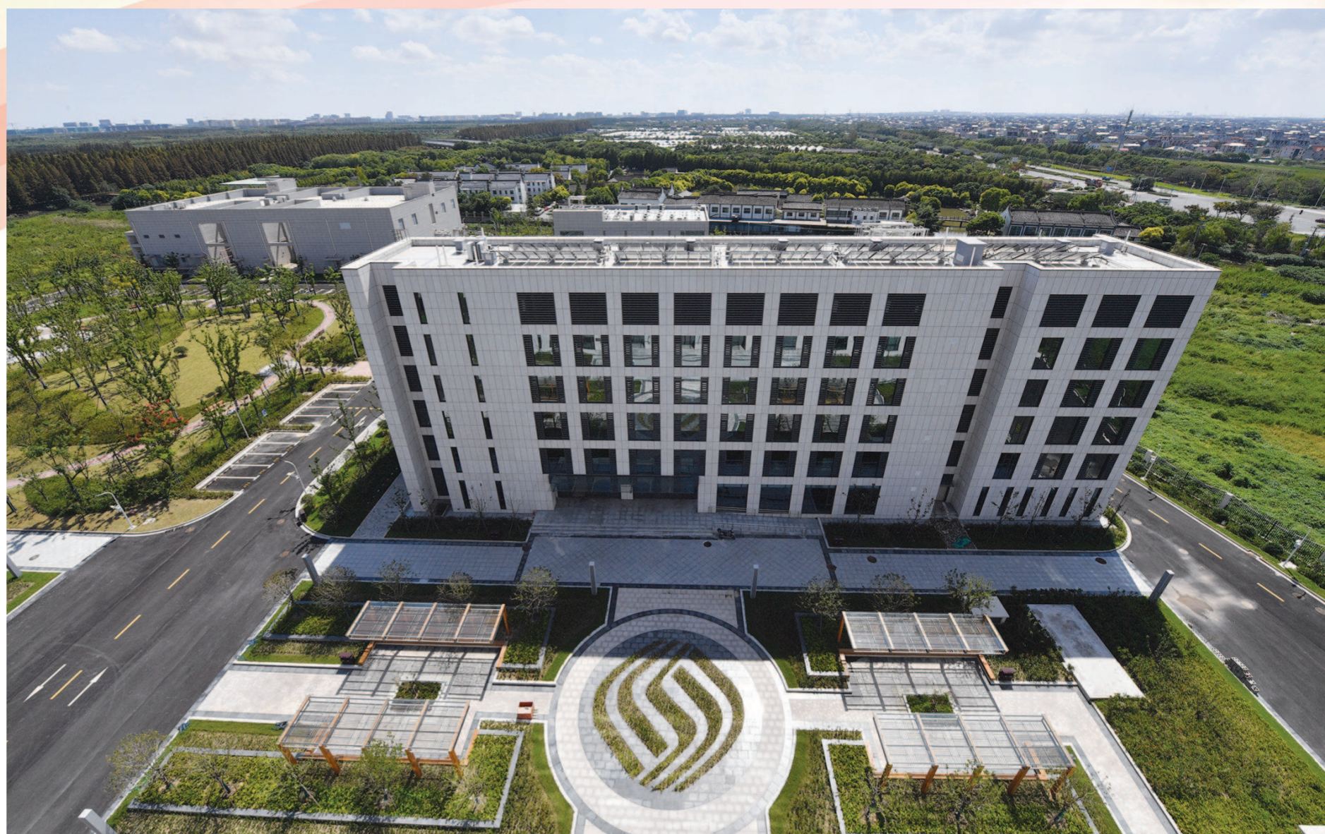
上海移动发挥优势做深做厚重要区域5G覆盖，多次完成浦东各项国际级会议通信保障，为上海自贸区高质量发展铺设好“信息高速公路”。聚力建设运维好上海移动临港数据中心，助力临港新片区建设立足长三角、面向亚太、通达全球的国际通信枢纽和国际信息港。 (均上海移动供图)
