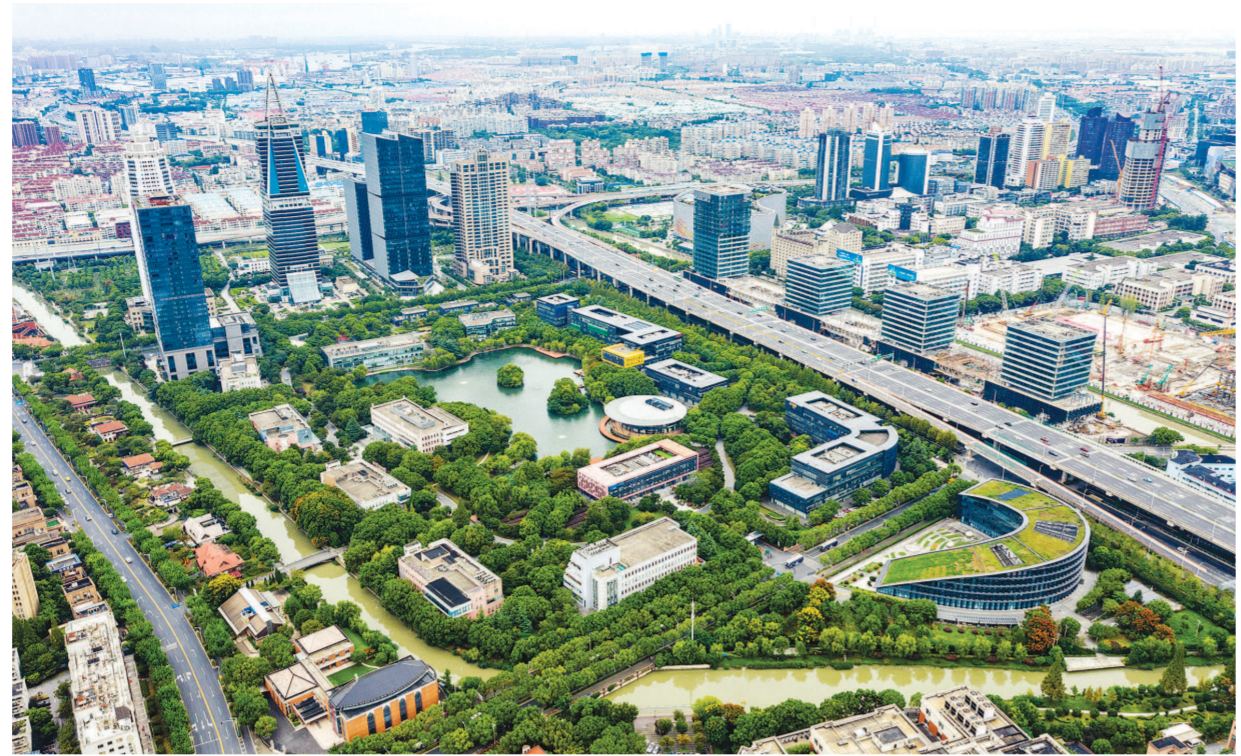
当下,上海自贸试验区围绕重点产业发展实际需要,深入推进制度型开放,加强改革整体谋划和系统集成,推动全产业链创新发展。 左图为金桥5G产业生态圈。本报记者 邢千里摄
