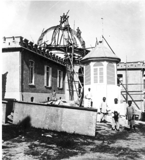
▲安装中的望远镜“穹顶”。
