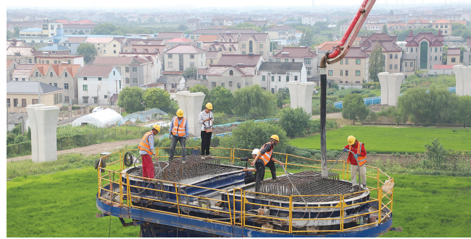
动车双线特大桥施工浇筑现场。(采访对象供图)
